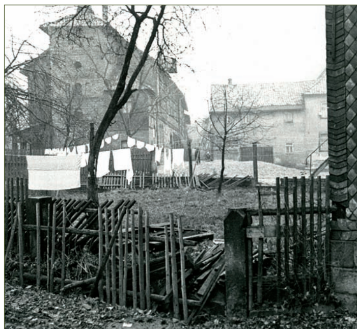
Blick von der „Unteren Allee“ zum „Häfenmarkt“ im November 1970. In der Bildmitte das Haus, dessen Keller freigelegt wurde.
