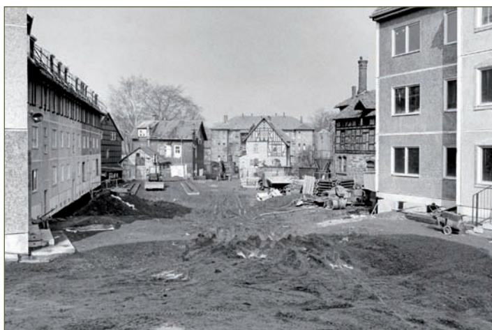
Blick auf die jetzt neu gestaltete Freifläche während des Baus der neuen Wohnanlage am Häfenmarkt, Ende der 1980er Jahre.
