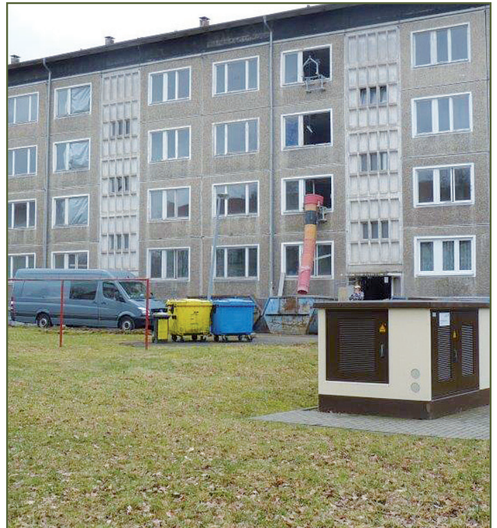
Weiter geht es mit dem 2. Bauabschnitt in der Rosa-Luxemburg Straße.
